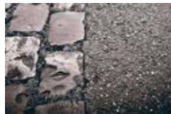
Brosten og asfalt
