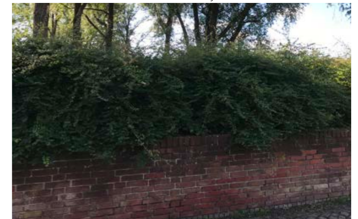
Støttemure i røde tegl
